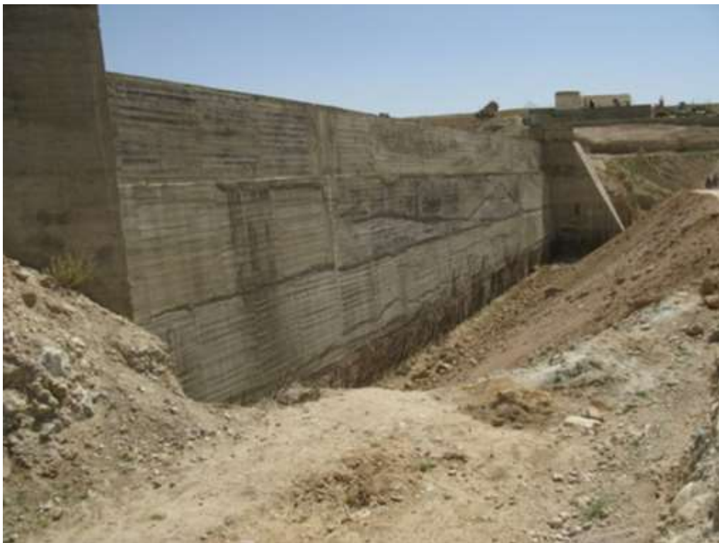
شکل ۱۸، ۱۱: د سلطان د بند د ترمیم د دیوال ترمیم شوی برخه (Stewart, 2009) د مارچ د ۲۰۰۵ کال ناکامی وروسته ۴ کاله د ترمیم پرمختګ ښيي.
