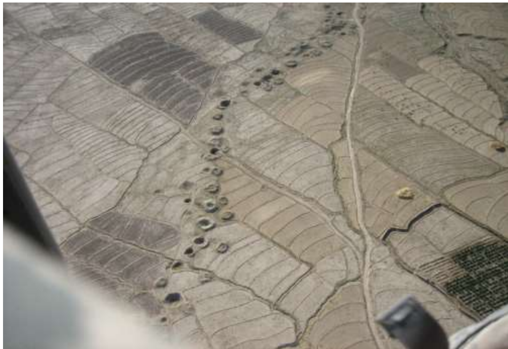
شکل ۱۲، ۱۵: د کاریز د سطحې د راسپړلو تصویر ځکه چې ځینې پټ شوي او ډک شوي دي. د هغې لامل دادی چې د ځمکې لاندې تونل راغورځیدلی دی، نو د هغې تر څنگه باید بل تونل وکښل شي.
